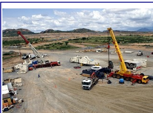
Der Aufbauplatz in der Mine
